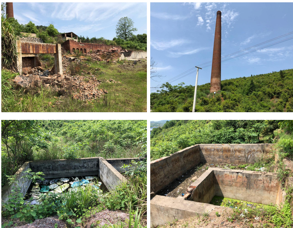
图 3-9 祁阳县茅竹镇钒冶炼厂场地内废弃的构筑物
